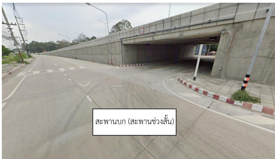
รูปที่ 10.2.2-3 ตัวอย่างรูปแบบจุดกลับรถลอดใต้สะพานบก (สะพานช่วงสั้น)
